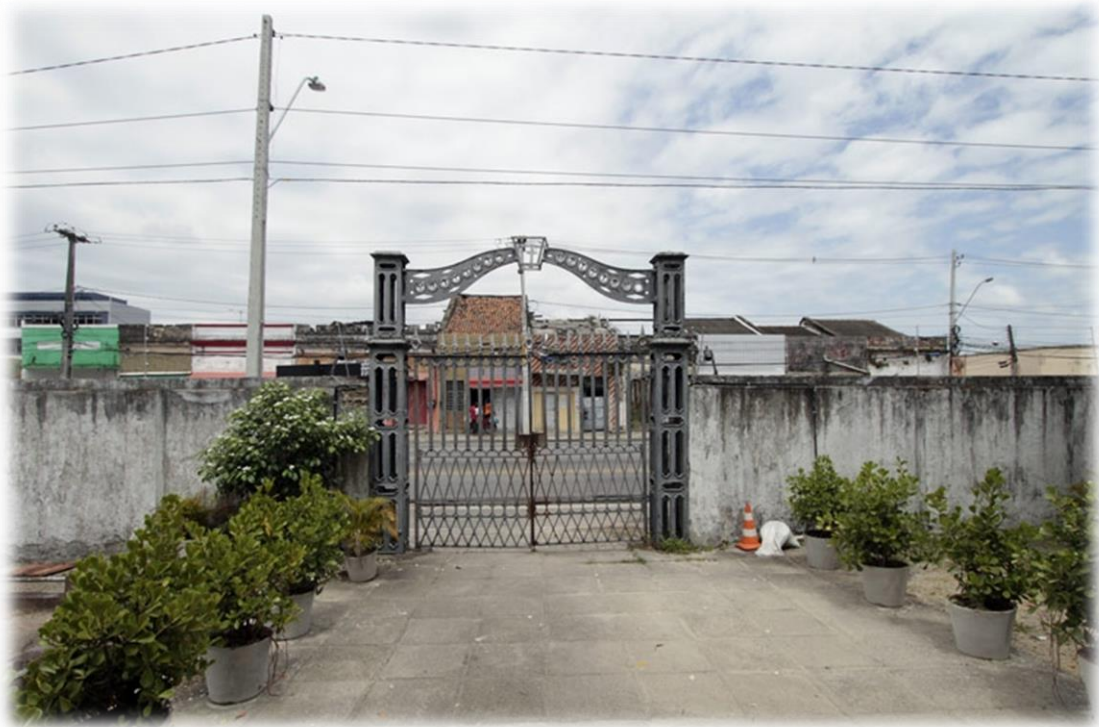
Figura 21 - Fotografia do portão de entrada e do passeio visto de dentro para fora.
