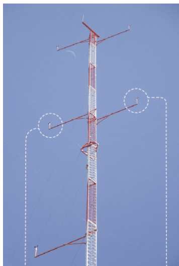
Figura 13: Estrutura de uma torre anemométrica Fonte: Atlas eólico, 2014.
