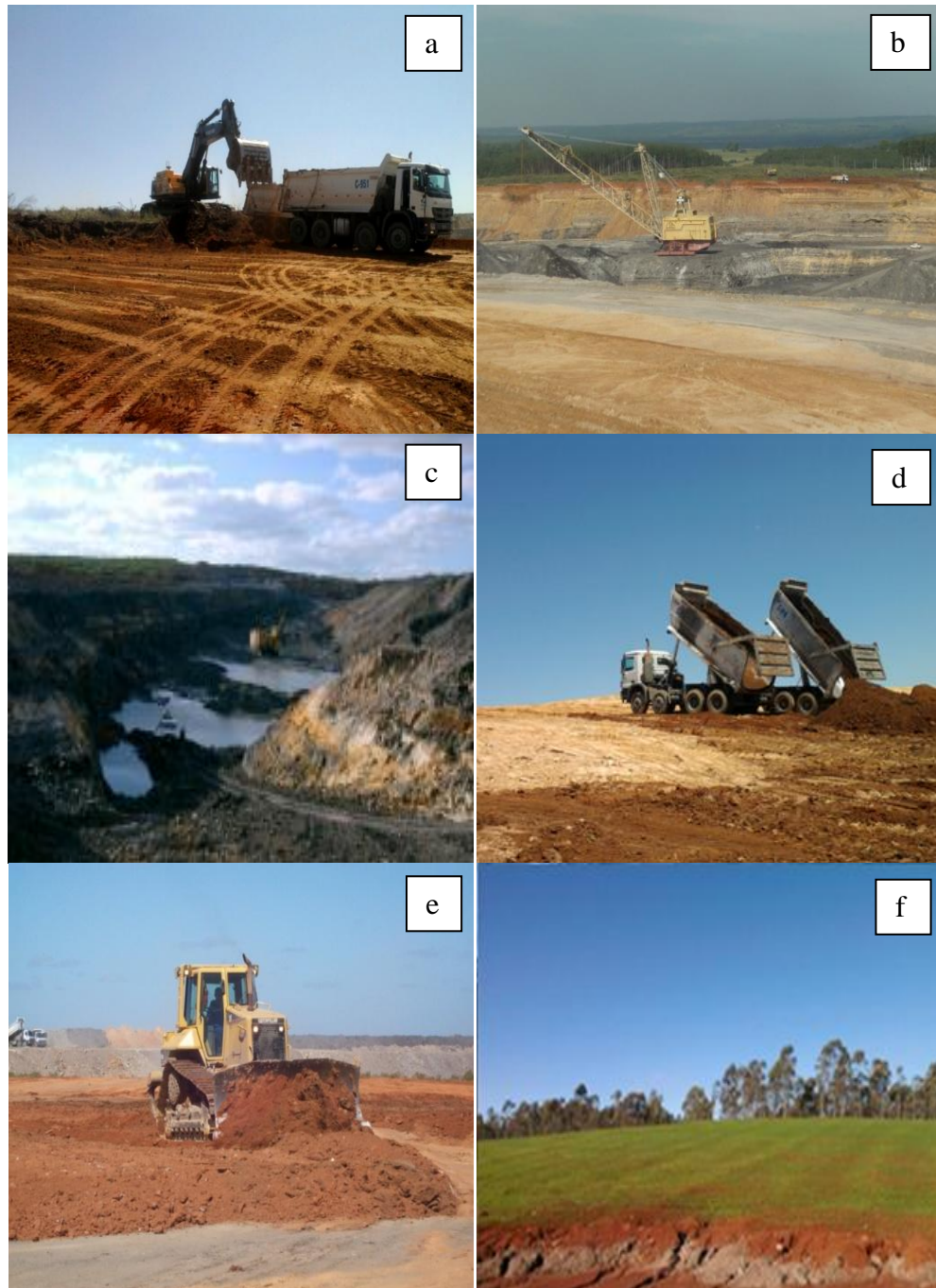
Figura 2 - Processo de mineração e recomposição topográfica da mina de Candiota-RS.
