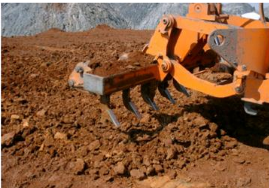
Figura 3: Escarificação (a) e calagem (b) do solo construído
