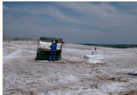
Figura 3: Escarificação (a) e calagem (b) do solo construído
