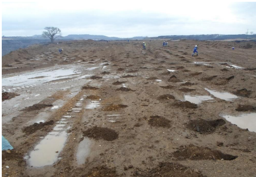
Figura 3 - Minesoil formado após recomposição topográfica na Mina de Moatize.
