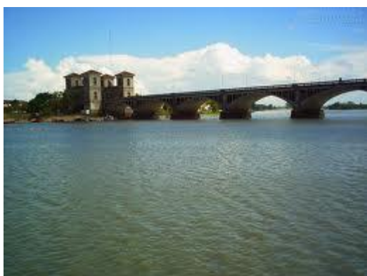
Figura 4 - Vista da ponte sobre o rio Jaguarão
