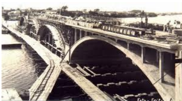
Figura 5 - Construção da ponte
