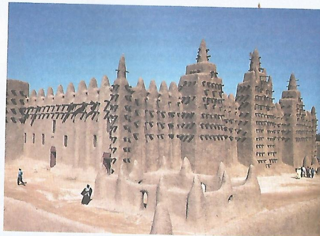
A mesquita de Djenné, a maior estrutura em adobe do mundo, foi construída em 1280 e reconstruída em 1907, no Mali, África. Fotografia de 2010.
