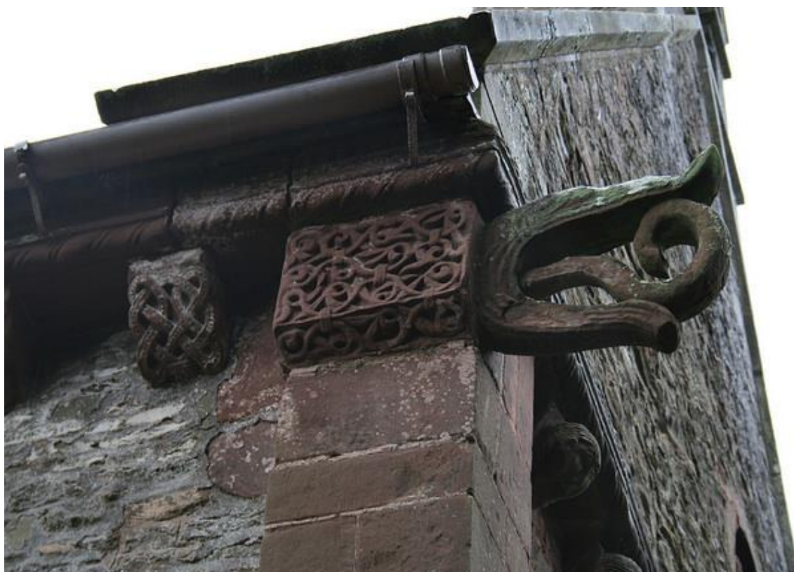
Imagem 38: Detalhe do contraforte da parede Oeste. Fonte: Disponível em https://flic.kr/p/FtnXPb , acessado pela última vez em 06 de julho de 2017.
