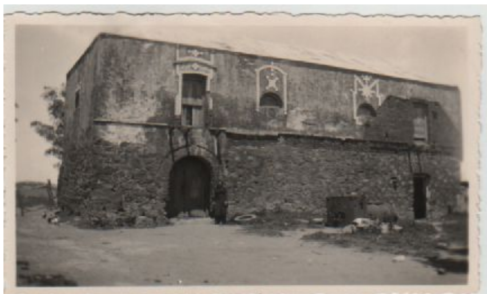
Figura 8 - Primeiro prédio da Capitania do Porto de Rio grande/RS em ruínas, século XIX 170 .
