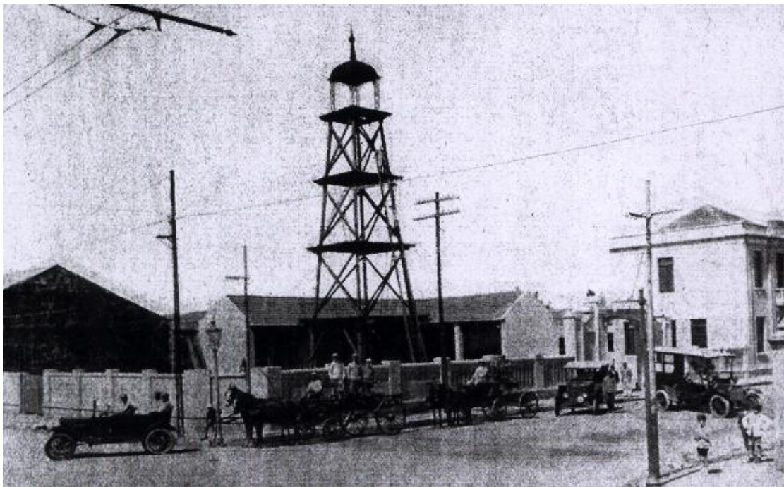
Figura 3. Prédio do Quartel do corpo de Bombeiros em Pelotas. Fonte: IHGPEL.
