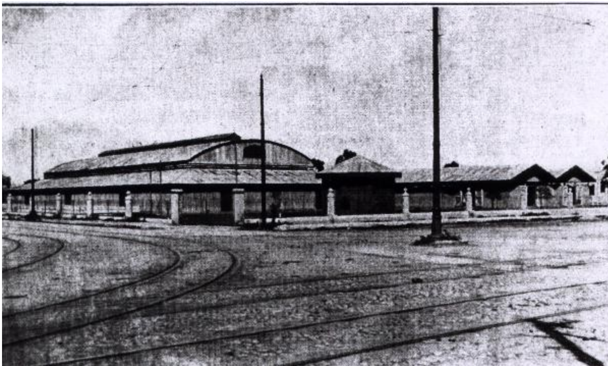
Figura 1. Prédio dos pavilhões da Sociedade Agrícola. Fonte: IHGPEL.
