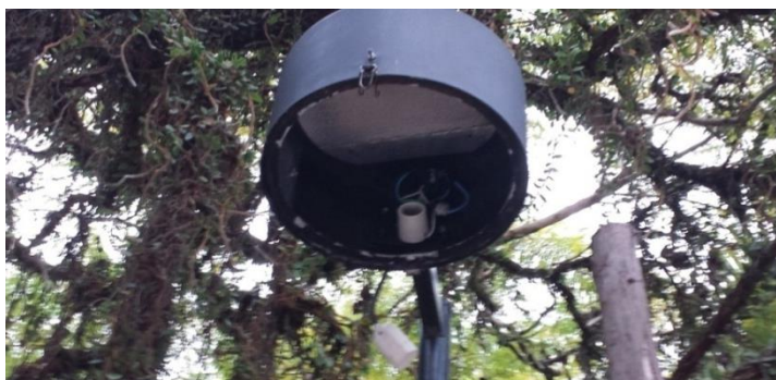
Figura 5- Tomadas de força elétrica junto aos postes de luz da praça.
