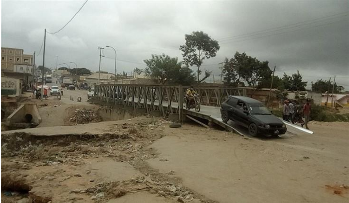
Figura 4 A segunda Ponte metálica
