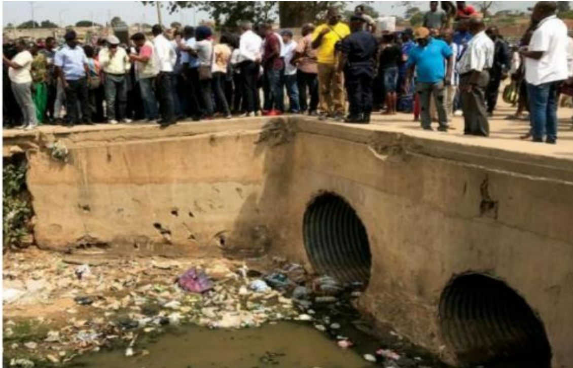
Figura 3 A primeira Ponte de concreto
