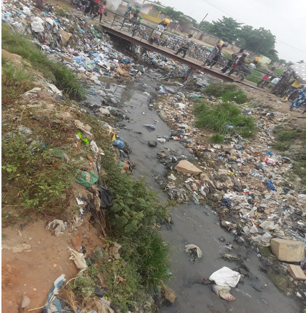
Figura 5 O estado atual da Ponte do Malweka
