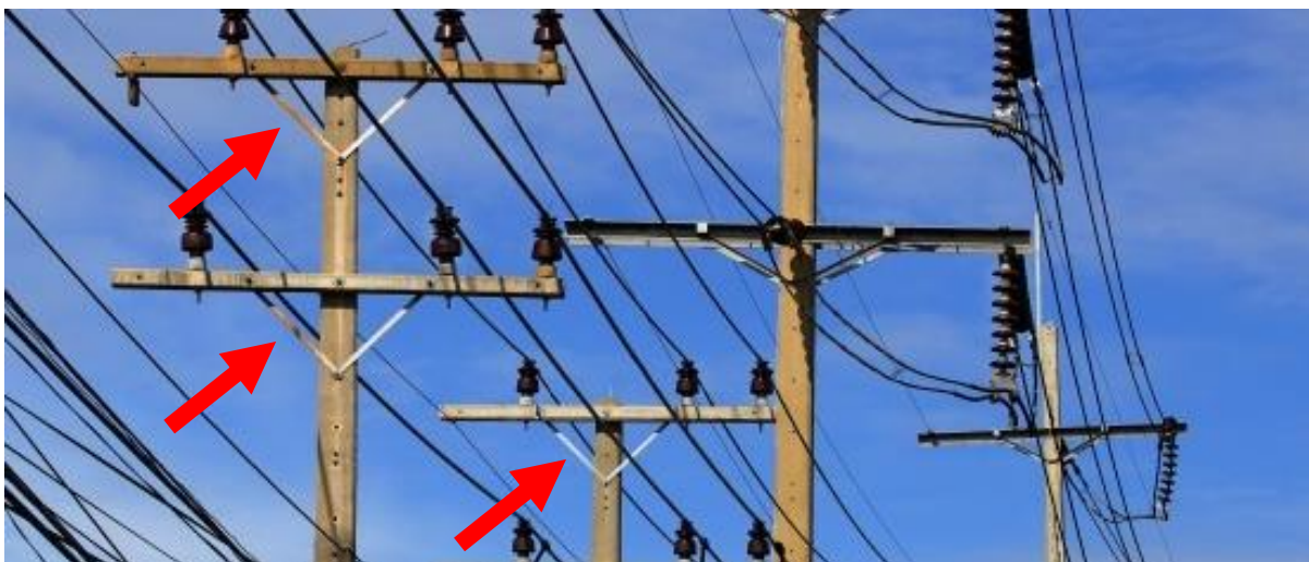
Figura 35 – Exemplo de aplicação de uma mão francesa plana.
