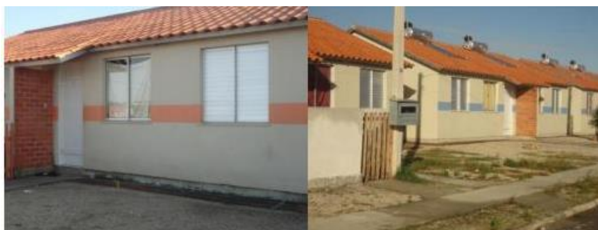
Figura 5 - Casas do Condomínio Residencial Eldorado
