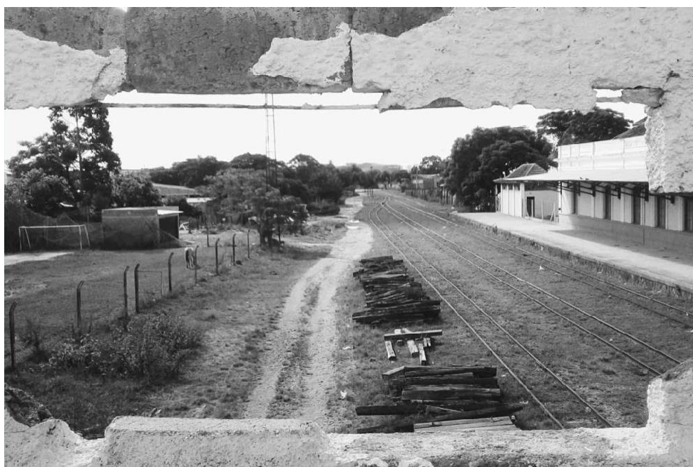
Figure 21 Fundos do prédio da Estação Férrea visto a partir de uma brecha da passarela. Foto: Andressa Pereira.
