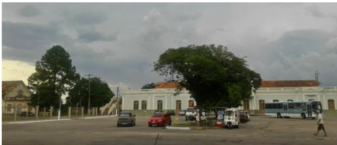
Figure 18 Entorno do prédio da Estação Férrea, localizado Bairro Simões Lopes Foto: Andressa Pereira, 2017.
