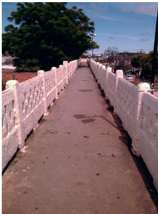
Figure 28 Passarela. Foto: Andressa Pereira, 2016.
