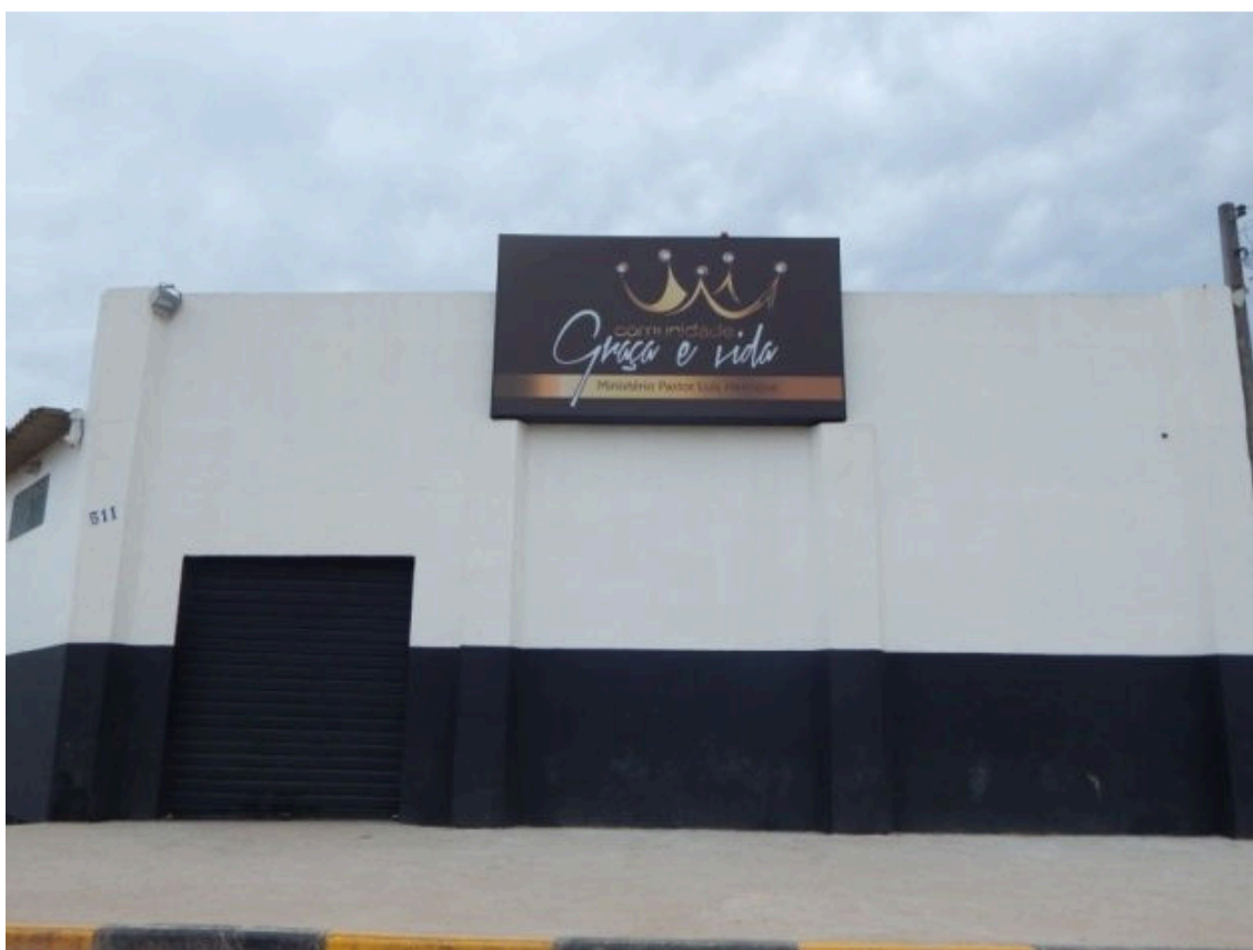
Figura 16 - Fachada de igreja (Igreja Graça e Vida).
