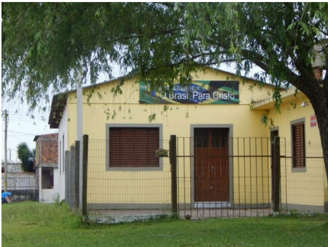
Figura 15 - Fachada de igreja (Igreja O Brasil para Cristo). Fonte: do autor, 2017.
