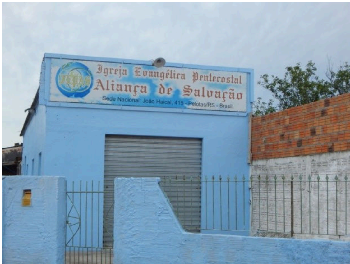
Figura 12 - Fachada de igreja (Igreja Aliança de Salvação).
