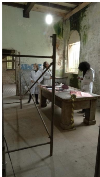
Figura 26 - Sala reservada para a intervenção. Foto: Jaime Mujica, 2015
