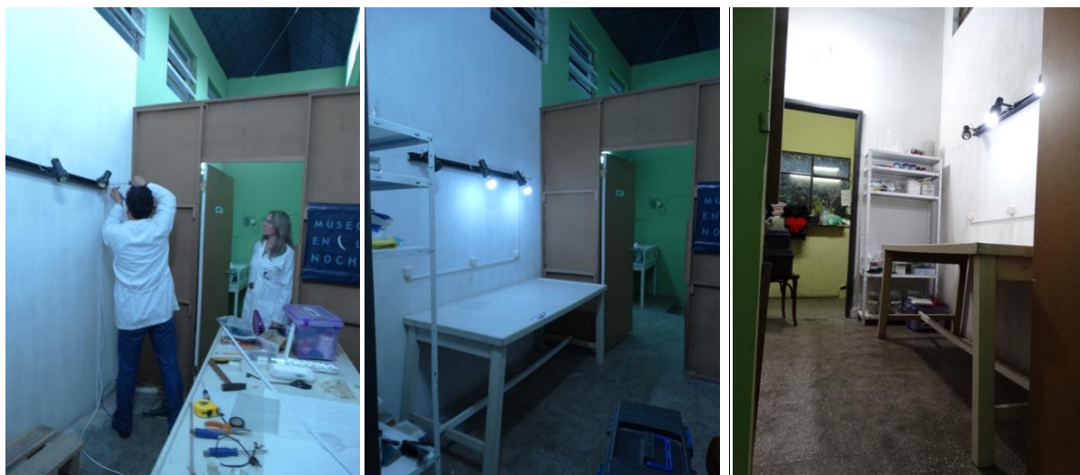
Figura 99 – Colocação da iluminação e tomadas, inclusão de uma estante de aço modulável para o armazenamento dos produtos químicos utilizados na conservação curativa. Foto: Jaime Mujica, 2015.
