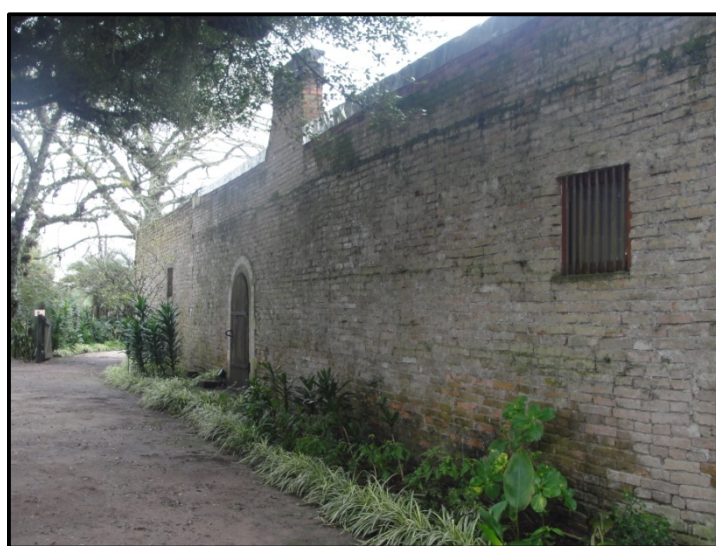
Figura 11 – Área da senzala/galpão com detalhe para a extensão do edifício e de suas aberturas (Charqueada São João). Fonte: Banco de Dados LEICMA, 2016.
