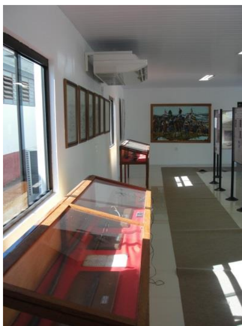
Figura 68. Sala de exposição climatizada, porém as vitrines ficam expostas a uma alta radiação solar proveniente das amplas aberturas sem proteção e orientadas ao Norte. Os vidros das vitrinas funcionam como uma estufa, resultando em microambientes com uma elevada temperatura e expondo também os artefatos a grandes intensidades de radiação ultravioleta.
