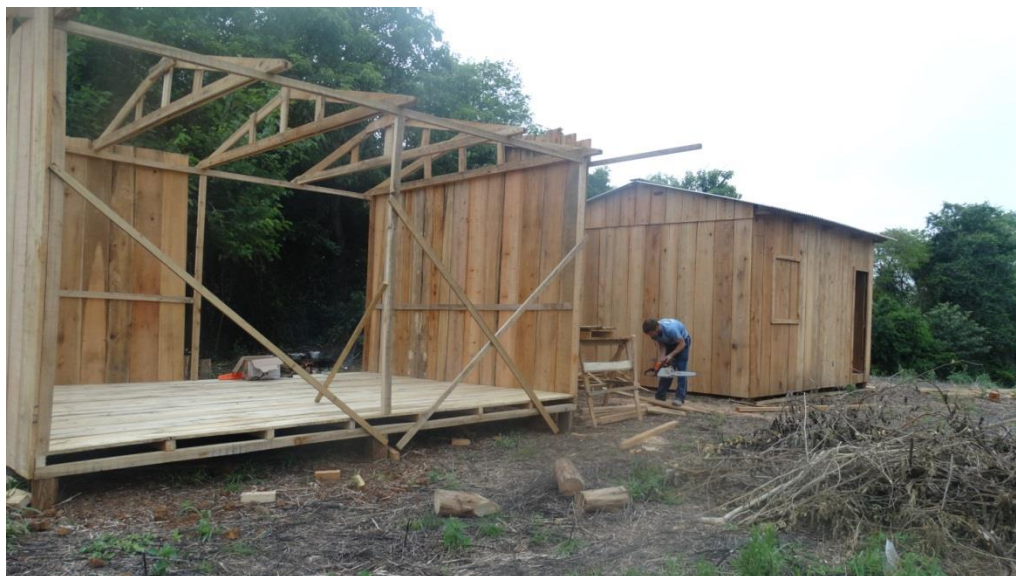
Figura 38 - Casas em construção Foto: Anildo Romeu. Acervo digital da autora, 2015.
