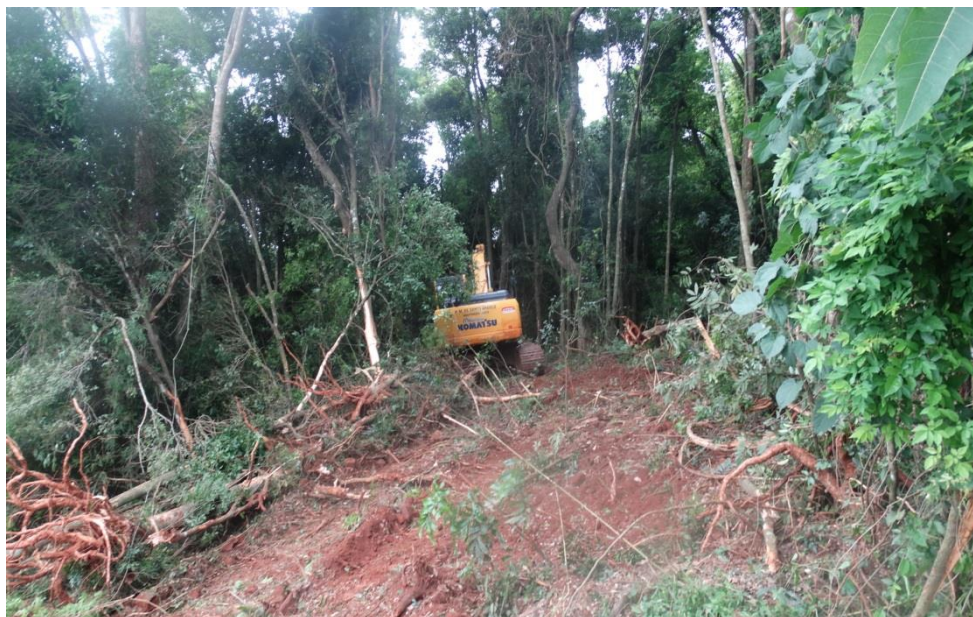
Figura 40 - Organizando para instalar a rede de água. Foto: Anildo Romeu. Acervo digital da autora, 2015.
