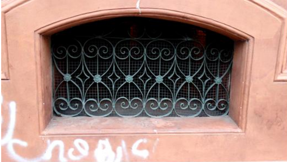
Figura 9 – Vista externa do porão, abertura para arejamento do porão. Fonte: autora.
