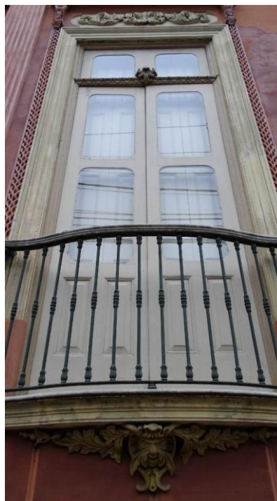
Figura 6 – Janela frontal com gradis e estuques. Fonte: autora.
