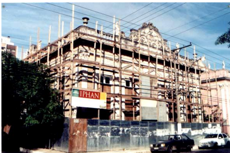
Figura 11 – Início das obras de restauro em 2002 pelo Programa Monumenta. Fonte: Acervo LEPAARQ.
