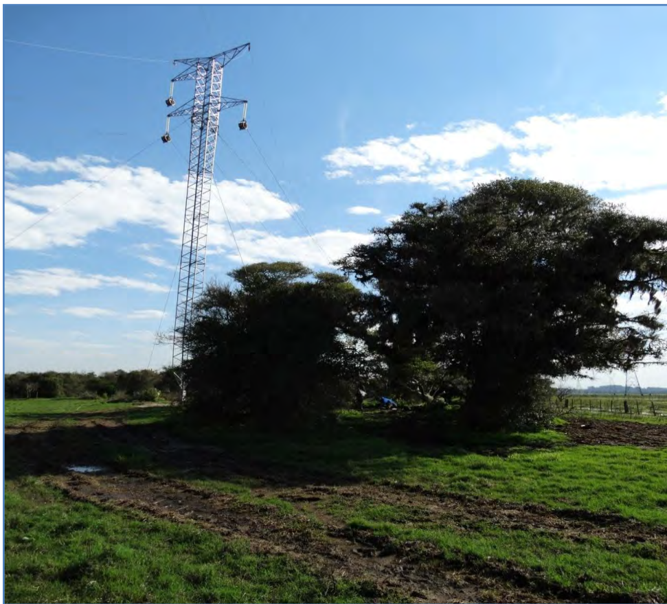
Figura 40: Imagem da torre de transmissão implantada sobre o sítio LF2. Foto do autor.
