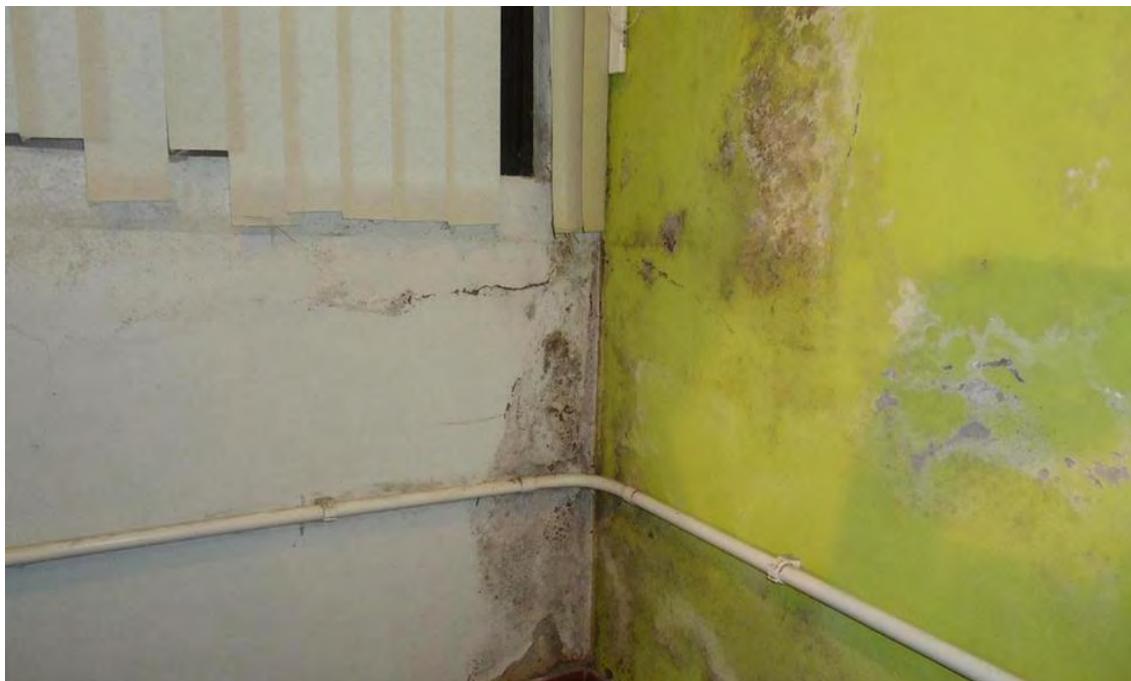
Figura 54 – Vista parcial de uma das paredes da Sala 2 com infiltração, consequentemente fungos e pequenos desprendimentos na camada de reboco, tudo muito próximo a instalações elétricas Fonte: ACERVO PESSOAL, 2014.
