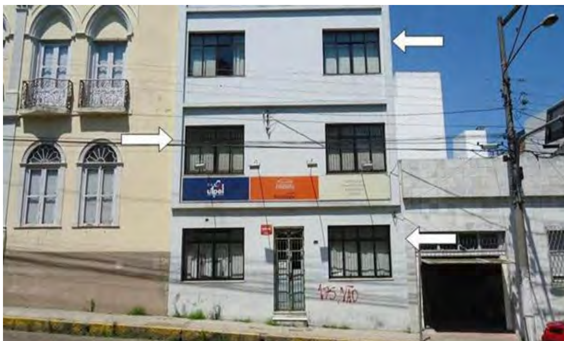
Figura 51 – Vista da parede frontal com as seis janelas de grandes dimensões, que resultam numa alta exposição aos efeitos da radiação luminosa Fonte: ACERVO PESSOAL, 2014.
