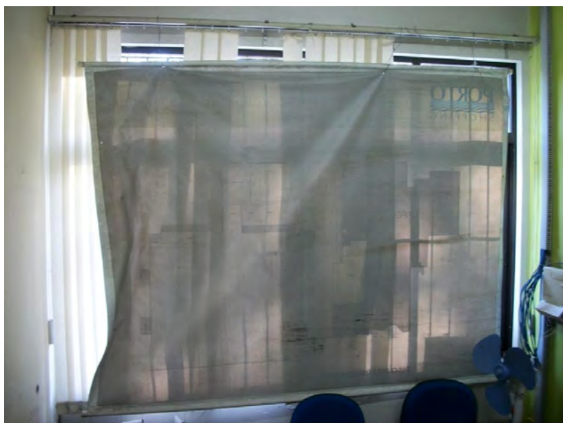
Figura 67 – Janela da Sala 1 mostrando a persiana em péssimo estado de conservação, assim como um bloqueio improvisado de lona Fonte: ACERVO PESSOAL, 2015.
