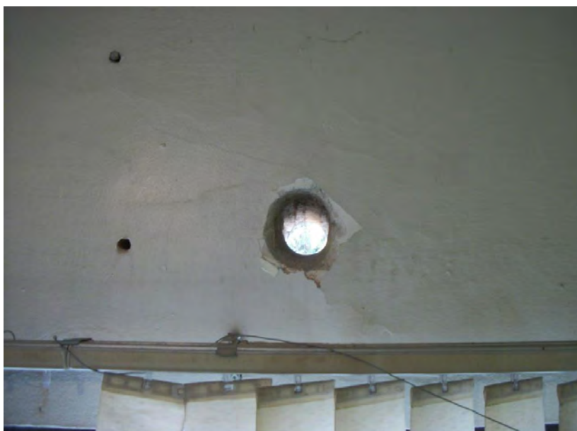
Figura 68 – Enorme buraco numa das paredes da Sala 2, devido à antiga instalação de ar-condicionado
