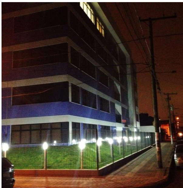
Fig. 9 - Bloco II Prédio Rua Álvaro Chaves, 65
