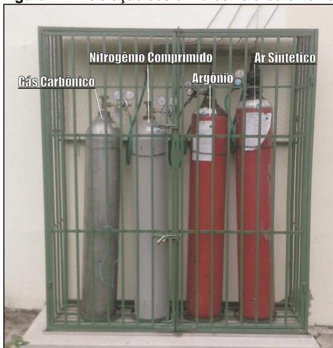
Figura 11: Instalação dos cilindros na área externa.
