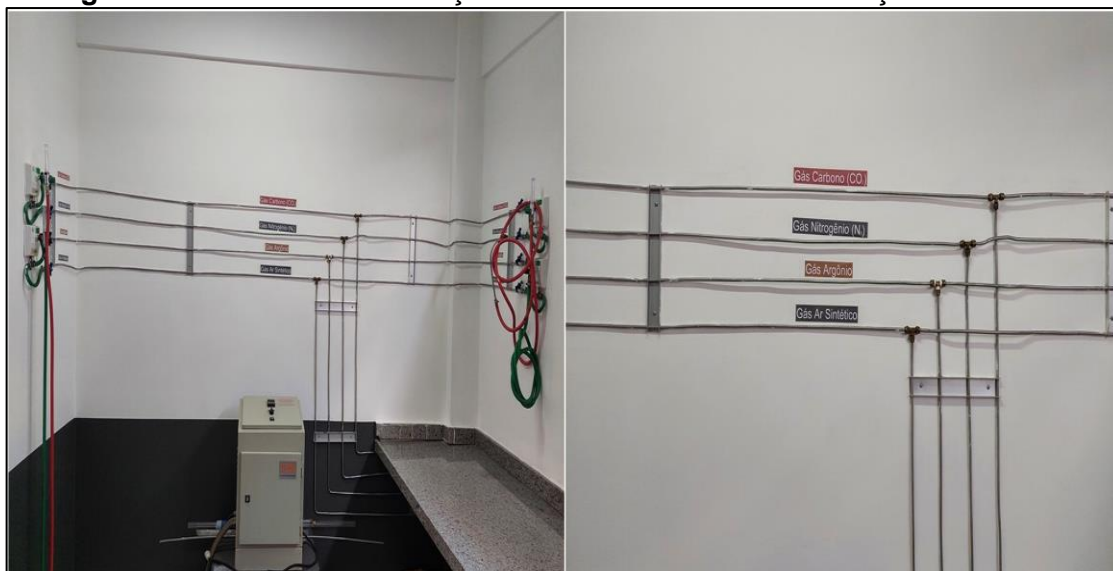
Figura 10: Realizada a instalação interno do sistema de tubulação do LabMat.
