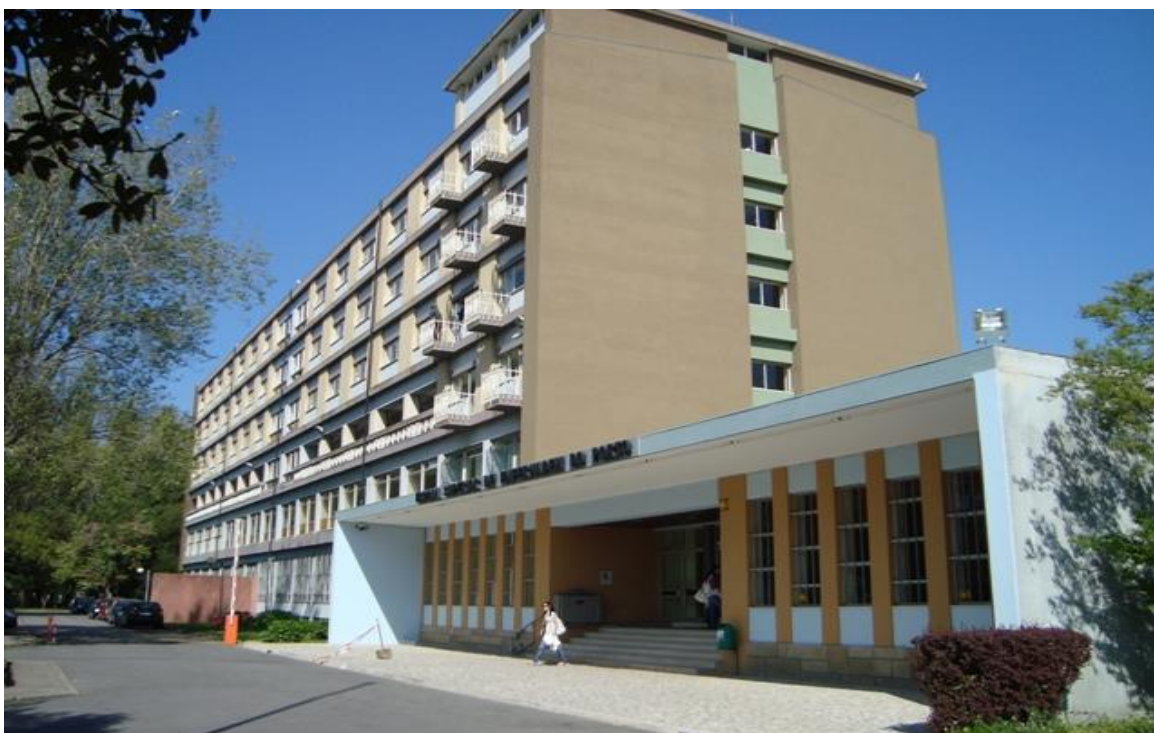
Figura 13- Escola Superior de Enfermagem de Porto-Portugal. Fonte: IMAGEM, 2014.
