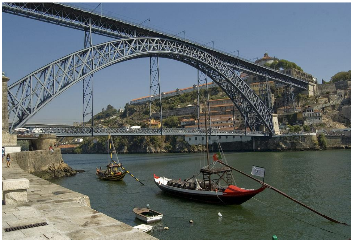
Figura 9- Ponte D. Luís I- Cidade de Porto- Portugal Fonte: IMAGEM, 2014.
