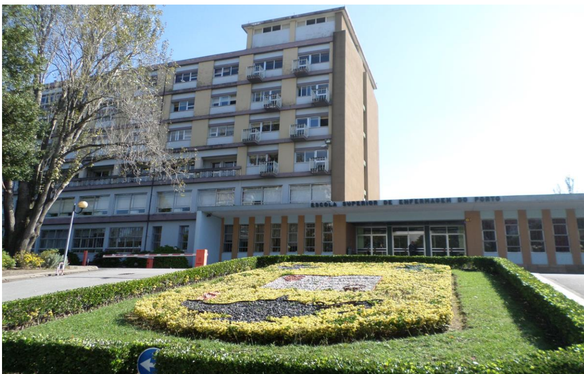
Figura 12- Escola Superior de Enfermagem de Porto-Portugal. Fonte: IMAGEM, 2014.
