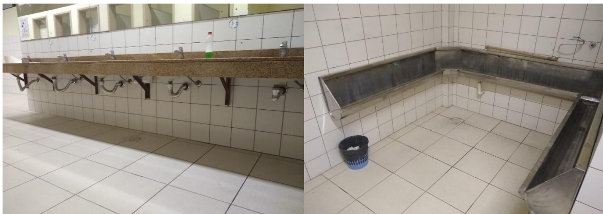
Figura 2 – Banheiro situado no segundo andar do Campus Anglo.
