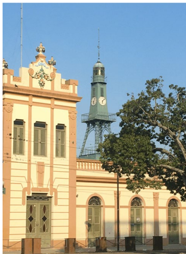
Figura 9: Foto do relógio do Mercado Público de Pelotas. Fonte: AUTORIA PRÓPRIA, 2022.
