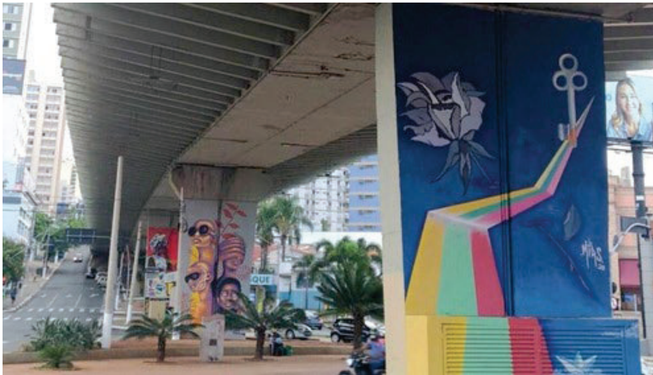
FIGURA 4 – Muros de sustentação do Viaduto 'Laurão'. FONTE: Embarque 40 Mais, 4 de dezembro de 2020.
