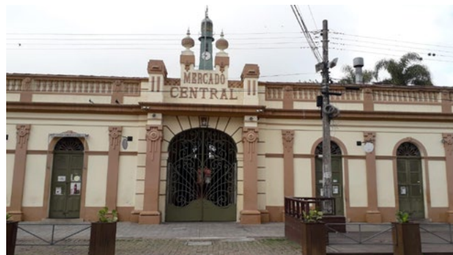
Figura 6: Foto do detalhe do Mercado Público. Fonte: AUTORIA PRÓPRIA, 2022.
