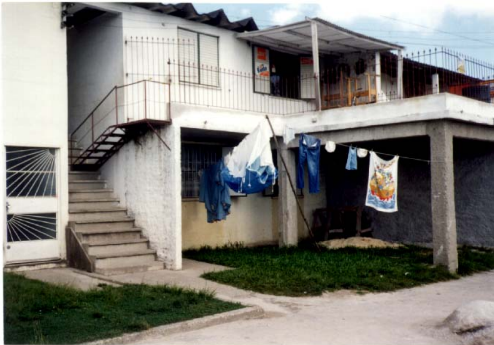
FIGURA 1- Tipologia habitacional: na esquerda as primeiras alterações; na direita a futura ampliação do térreo é o terraço com o boteco do segundo andar.
