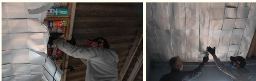
>>> Oficinas de painéis de isolamento térmico com reciclagem de embalagens Tetrapack nas unidades do PAC Anglo. Autor, 2021
