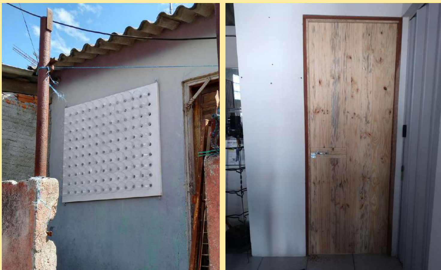
Figura 27. O dispositivo de Eco-cooler e o dispositivo da porta isolante. Acervo dos autores, 2021.
