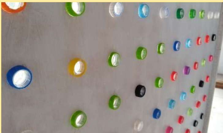
Figura 28. O dispositivo de Eco-cooler . Acervo dos autores, 2021.
