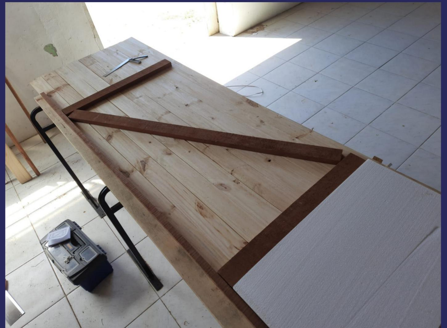
O interior da porta é preenchido com isopor para auxiliar no conforto térmico.
