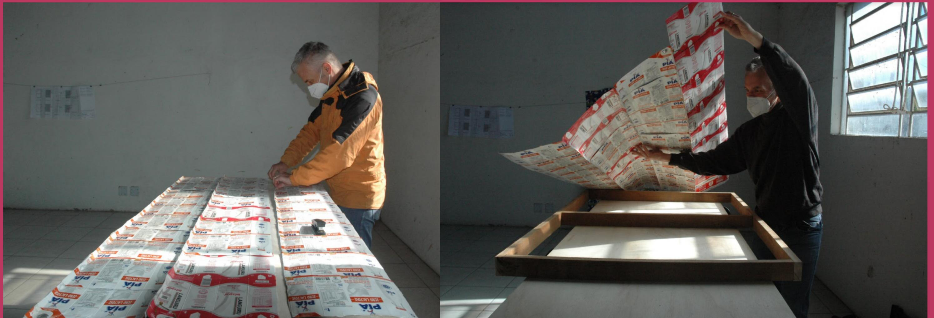
As mantas são grampeadas entre si e depois grampeadas na estrutura de madeira. O interior do módulo é preenchido com caixas Tetra Pak inteiras, auxiliando na estrutura das mantas.
