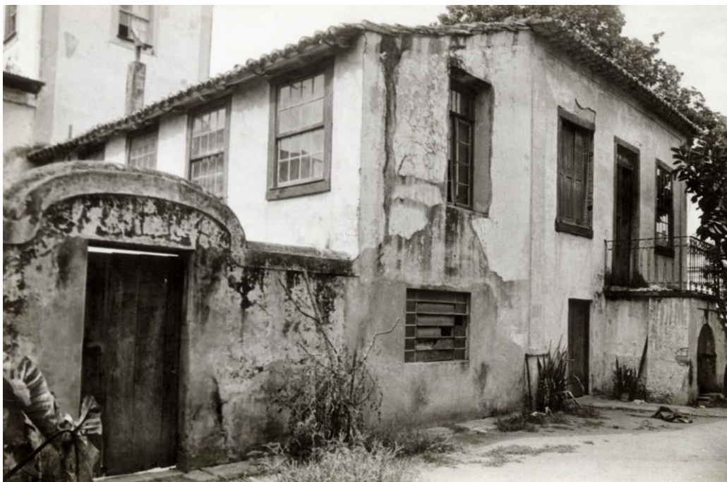
Figura 2: Vista da fachada lateral do Solar em ruínas
