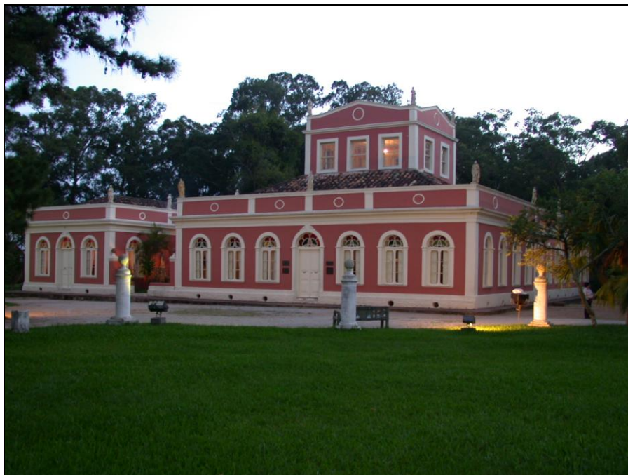
Figura 7: Fachada do Museu Municipal Parque da Baronesa (Fonte: F. Laureano)
