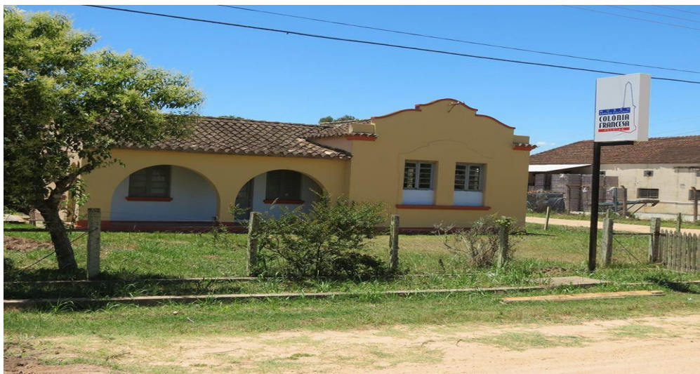
Fachada do prédio Museu da Colônia Francesa
