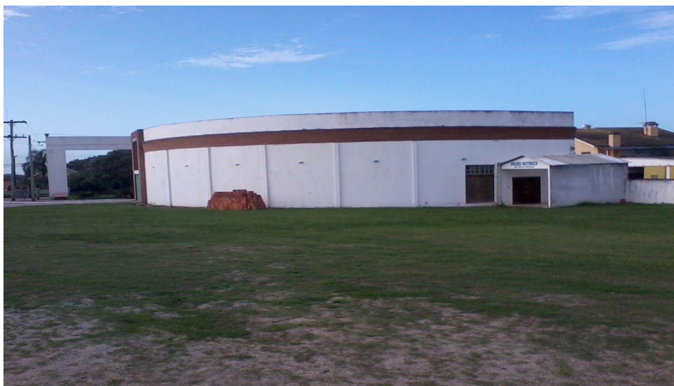
Fachada do prédio Museu Histórico de Morro Redondo
