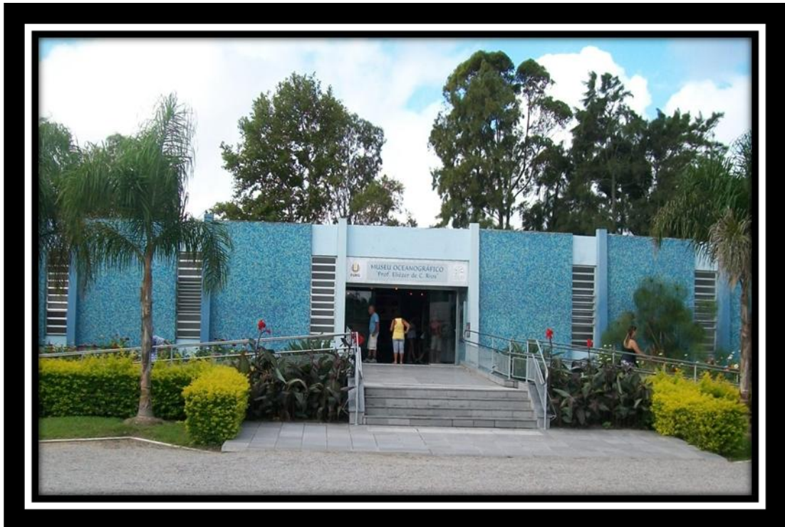
Figura 15: Fachada depois da reforma. Fonte: Arquivo Pessoal da Autora.
