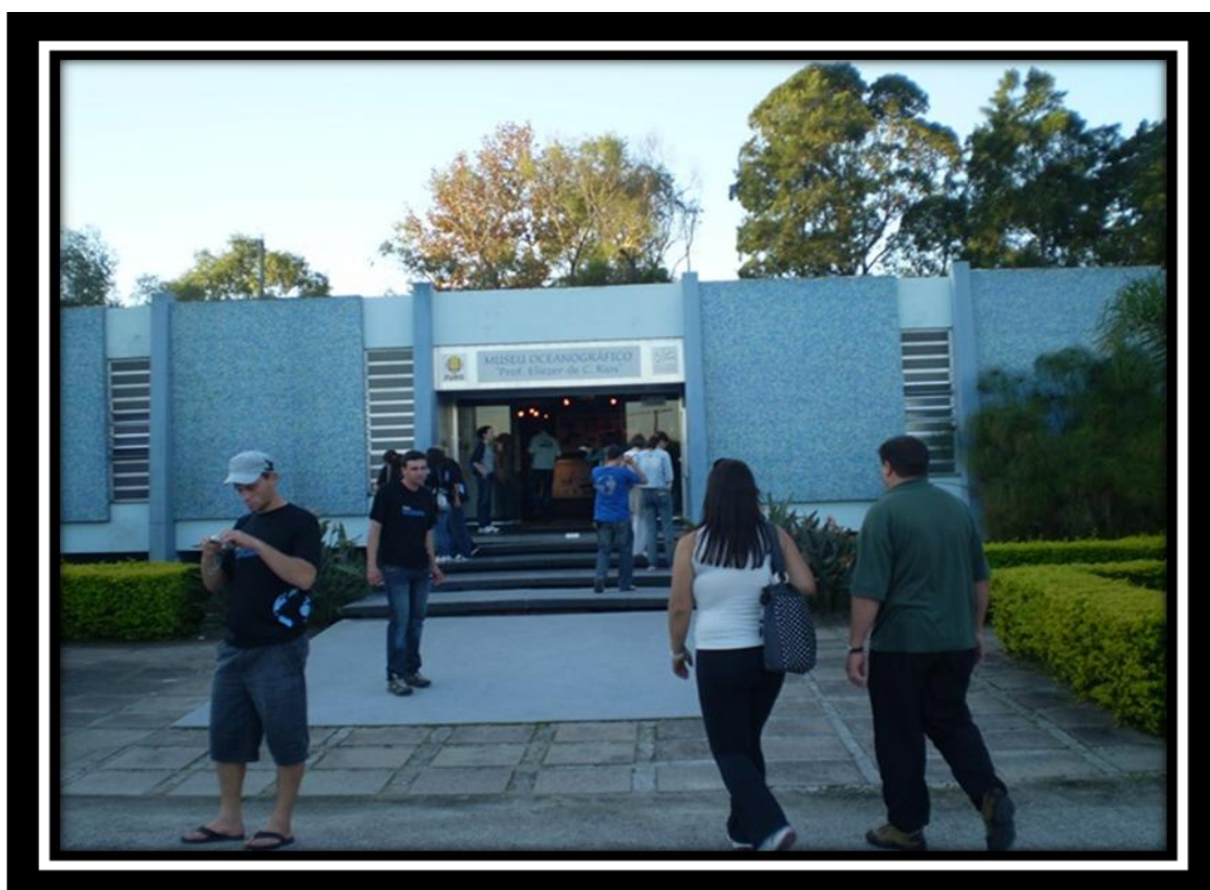
Figura 14: Fachada do Museu Oceanográfico antes da reforma. Fonte: www.google.com.br .
