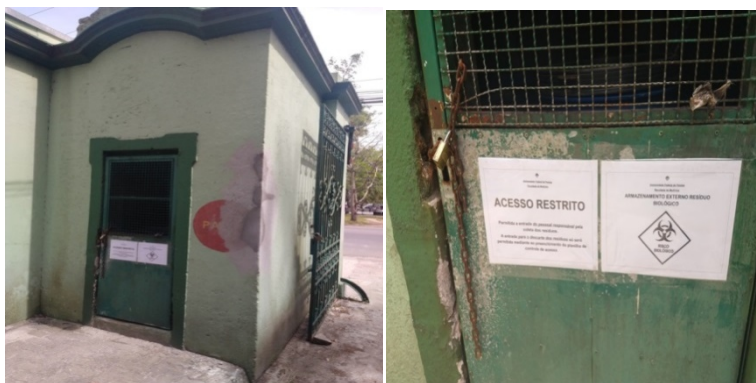
Foto 4. Vista geral e detalhe de sinalização do depósito temporário resíduos biológicos e perfurocortantes.
