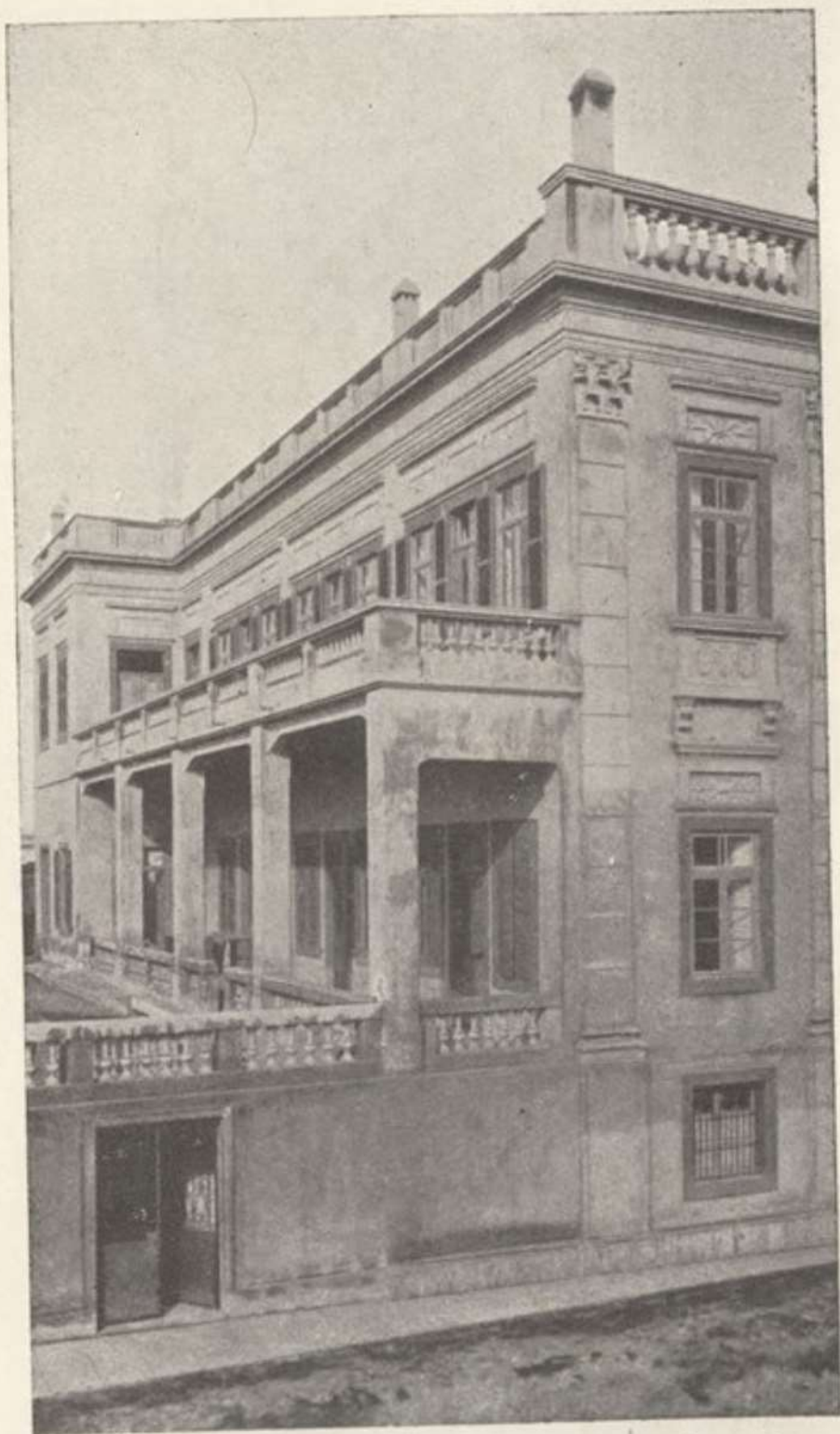
O Pavilhão Baronessa do Arroio Grande Face posterior
