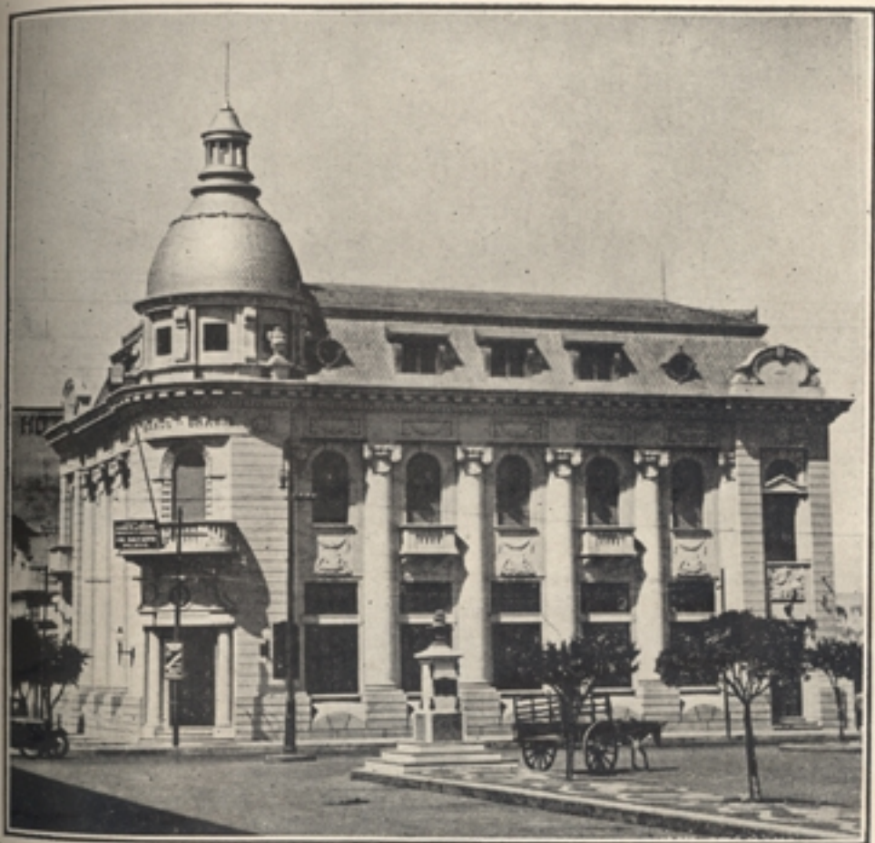
O NOVO EDIFÍCIO DA FILIAL DO BANCO DO BRASIL
