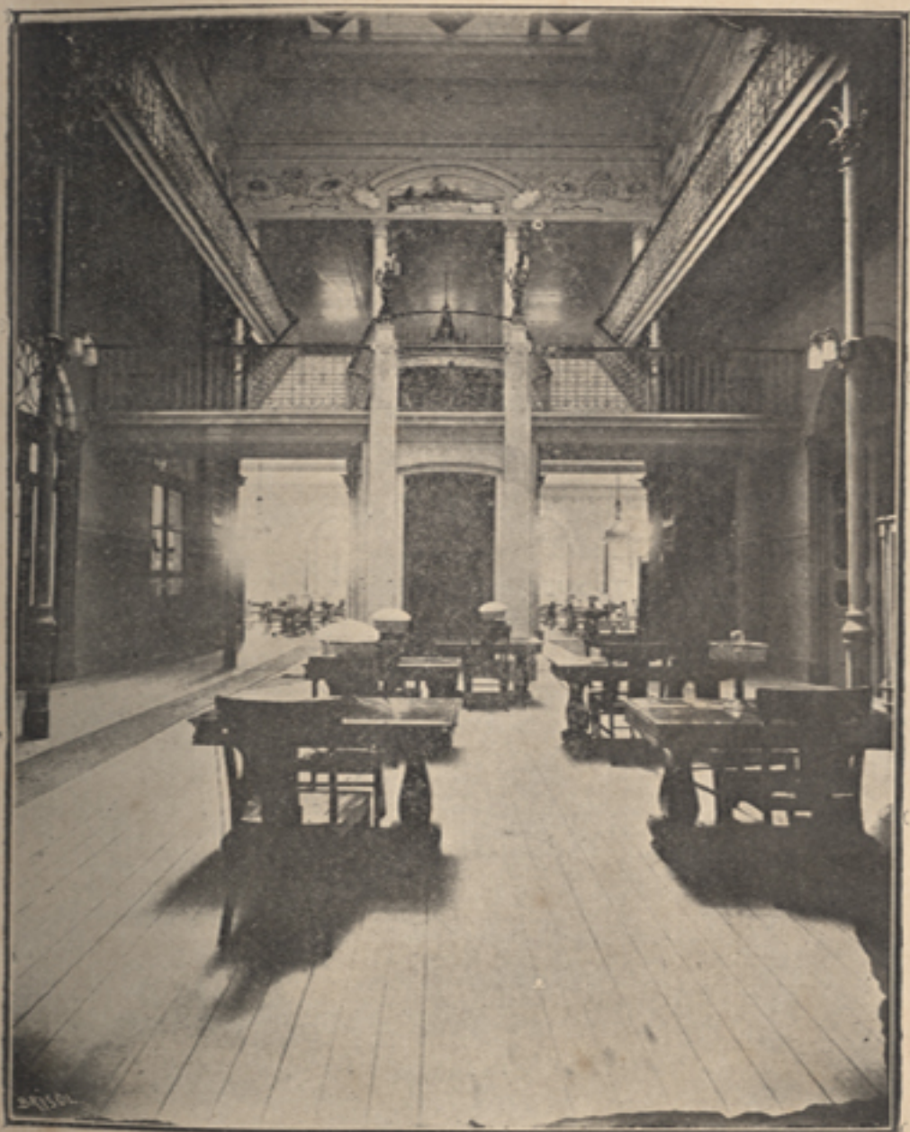
Vista geral da Bibliotheca, vendo-se o patamar, escada e galeria
