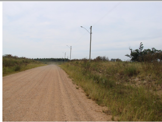
Imagem 4: Estrada do Quebracho. Bagé.
