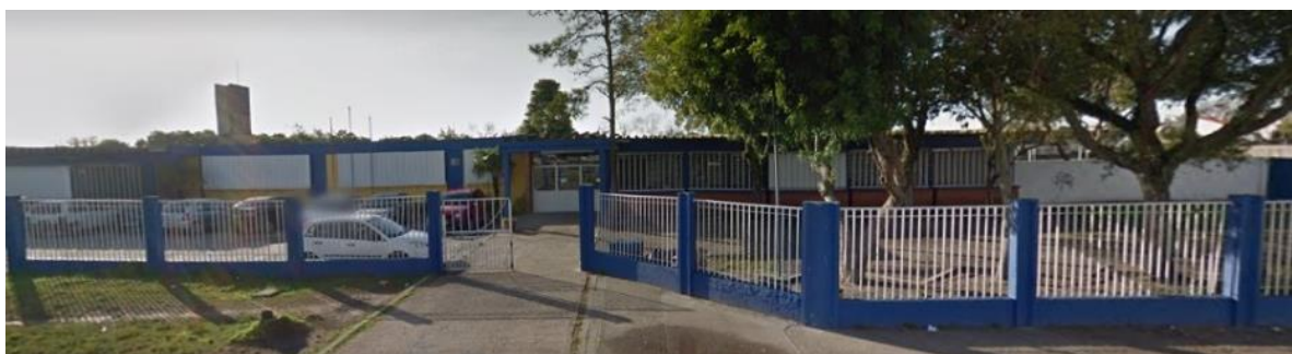
Figura 1: Colégio Estadual Dom João Braga
