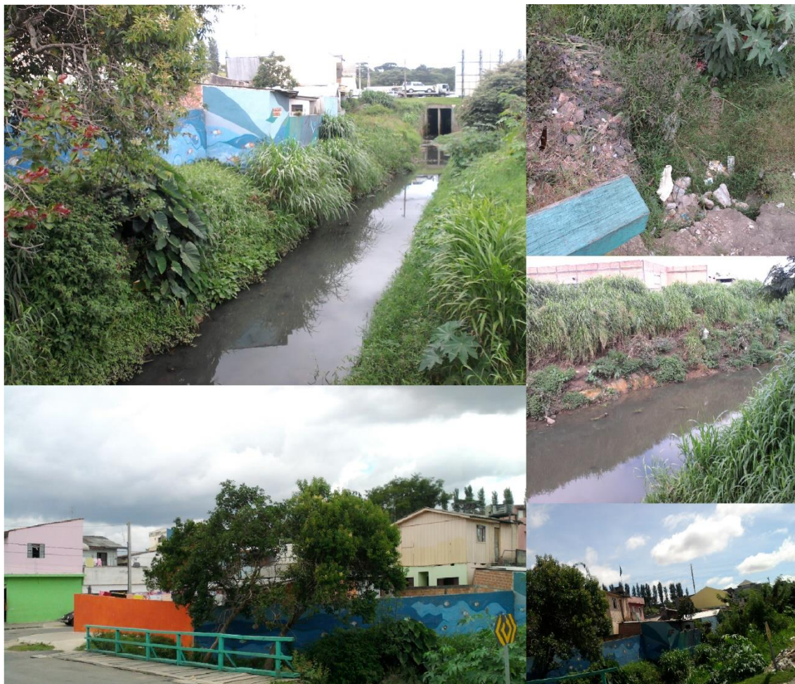
Figura 6 – Exemplo de ocupações irregulares no entorno do rio Belém
