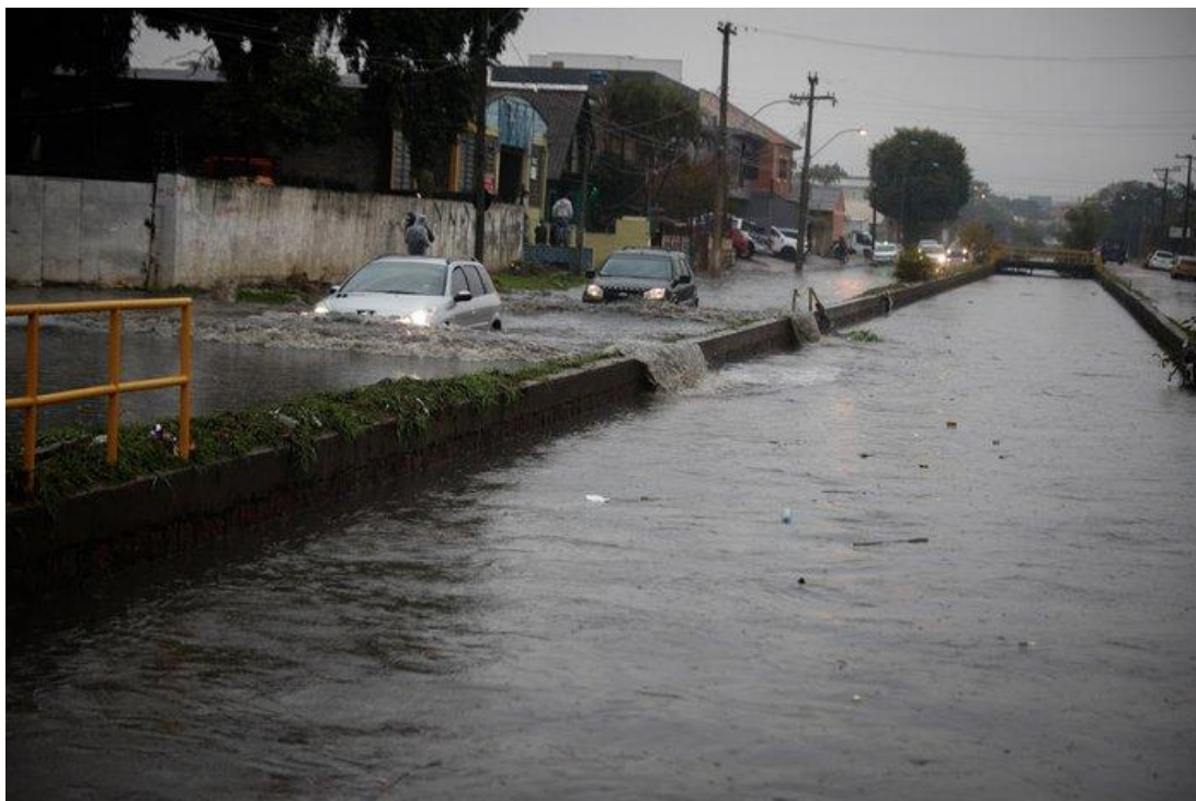
Figura 8 - Arroio Sarandi canalizado
