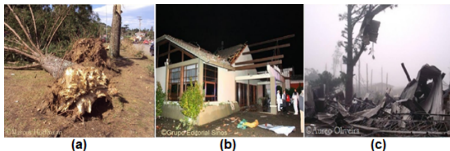
Figura 4 – Fotos da destruição ocorrida na cidade de Canela - RS, 21/07/2010
