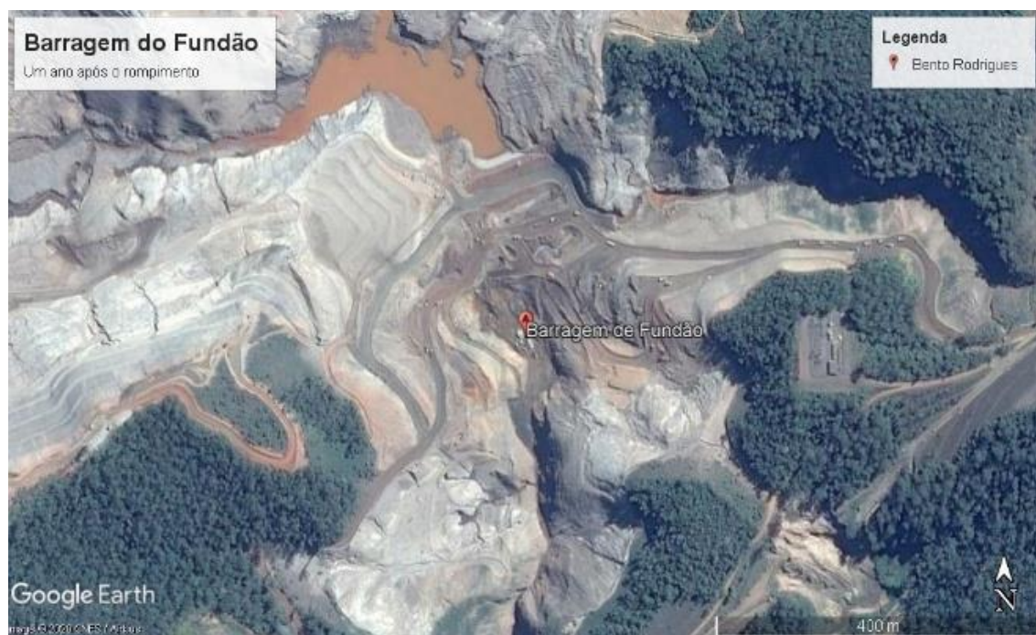
Figura 8 - Comparação temporal imagem um ano após o rompimento da barragem. Fonte: Google Earth.
