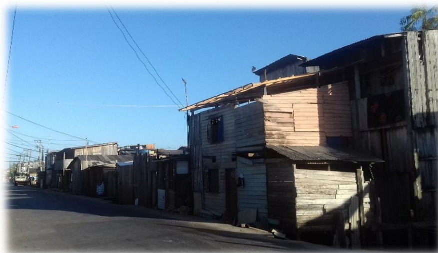
Figura 05 – Fotografia da Rua Estrada Nova com suas palafitas e estâncias fincadas em cima do canal
