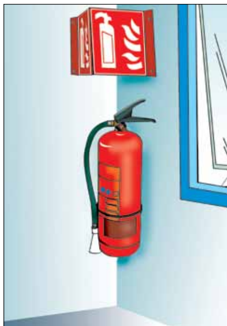
Figura 81a. Forneça extintores de incêndio suficientes em lugares claramente designados dentro das áreas de trabalho.
