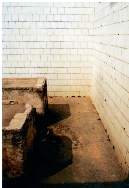
Figura 2: Vista do local do acidente – final da rampa
