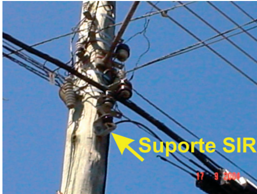
Figura 4: Suporte SIR envolvido no acidente, com inclinação aproximada de 45°. O pino de sustentação da castanha não possuía trava de segurança (contra-pino). Foto colhida e cedida pela empresa
