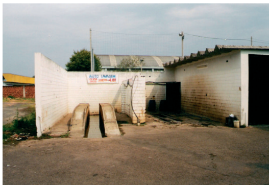
Figura 1: Vista do local do acidente
