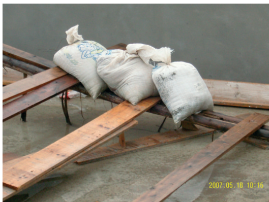
Figura 5: Detalhe do sistema de fixação dos andaimes
