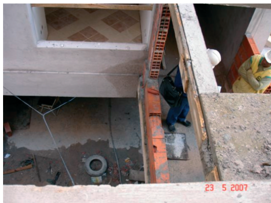
Figura 2: Área onde estava o elevador, vista da janela do acidente
