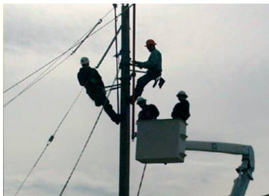
Figura 6: Algumas possibilidades de realização de atividades, com razoável confiabilidade, em rede aérea elétrica e de telefonia, com utilização de veículos dotados de plataformas elevatórias projetadas para uso humano
