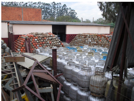
Figura 5: Pátio lateral/fundos lotado de botijões (cedida pelo Corpo de Bombeiros)
