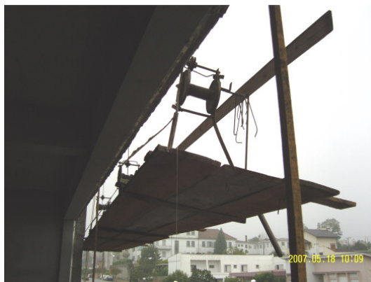
Figura 2: Detalhe do andaime
