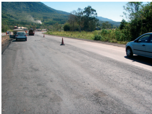
Figura 4: Espaçamento dos cones sinalizadores na pista
