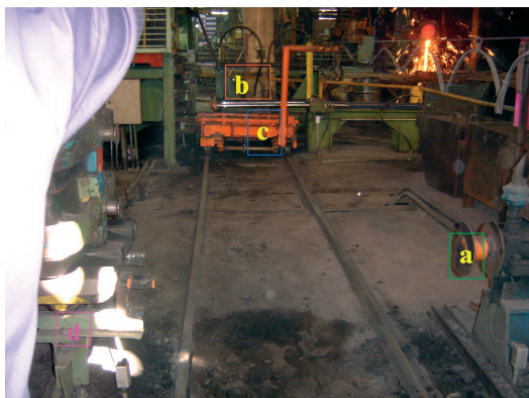
Figura 4: Vista lateral da linha de moldagem, da posição do perímetro desguarnecido indicado pela seta amarela na Figura 3
