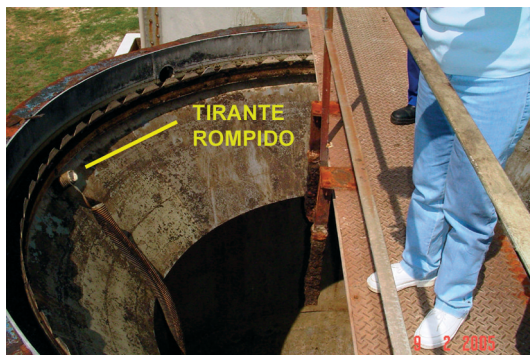
Figura 2: Tirante rompido
