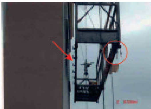
Figura 2: Detalhe do andaime
