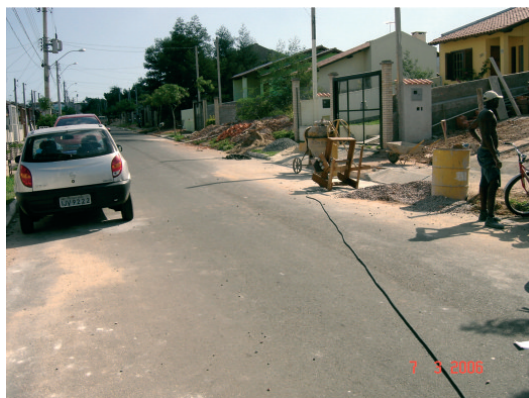
Figura 2: Fiação elétrica no meio da rua
