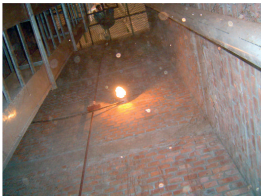
Figura 1: Poço de elevador onde ocorreu o acidente de trabalho
