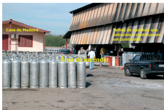
Figura 12: Telhas do pavilhão que entraram e continuaram em combustão e casa de madeira sem dano algum
