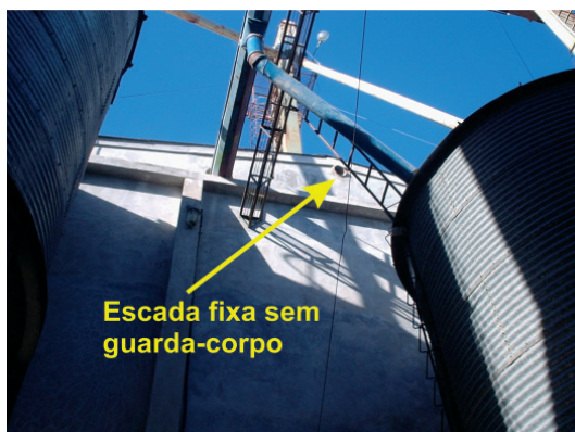
Figura 3: Escada para acesso do topo do silo ao telhado do armazém
