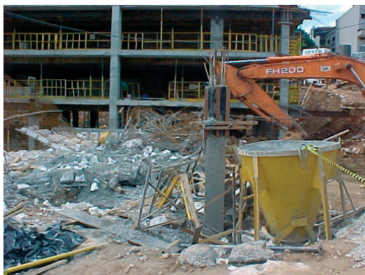
Figura 3: Retroescavadeira utilizada na concretagem
