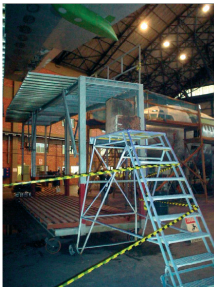
Figura 3: Vista de outro ângulo, da reconstrução do meio de acesso à doca modular. Observe-se a ausência do módulo da doca correspondente à escada e às improvisações utilizadas
