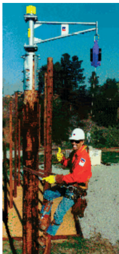
Figura 7: Uso de sistema trava-quedas individual para trabalho em postes
