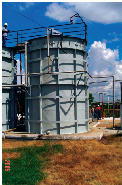
Figura 1: Tanque reator onde ocorreu o acidente
