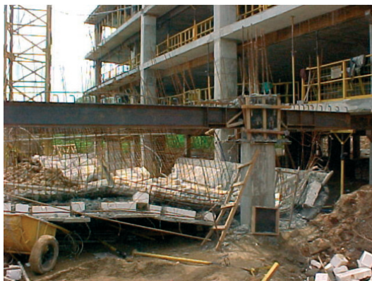
Figura 1: Detalhes da vigas metálicas, dos pilares concreto e da gerica
