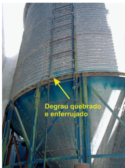
Figura 2: Escada tipo marinheiro, para acesso ao topo do silo existente na área externa do armazém
