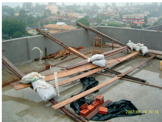
Figura 4: Sustentação do andaime com sacos de areia
