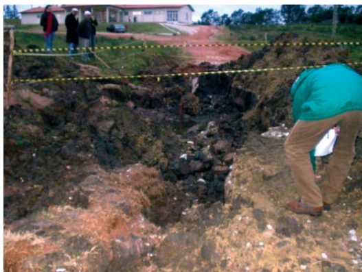
Figura 1: Vista do local do acidente
