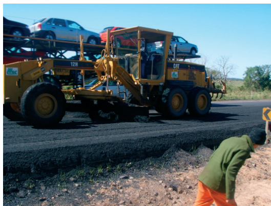
Figura 5: Trabalhos de recapeamento asfáltico em meia pista e fluxo da BR 101 na outra pista
