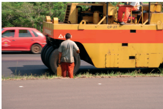
Figura 3: Vista da tarefa de pulverização dos pneus do rolo compactador
