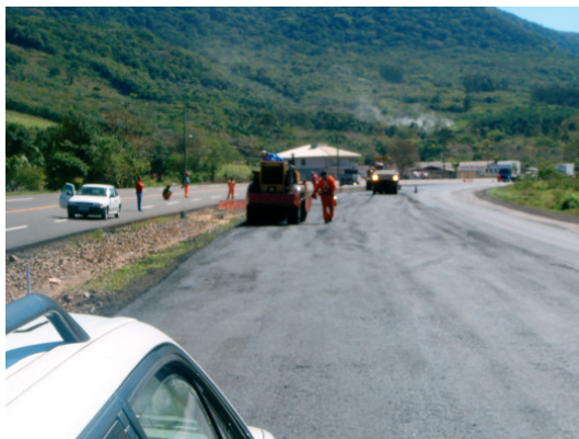
Figura 1: Vista geral de trabalhos na pista da BR 101
